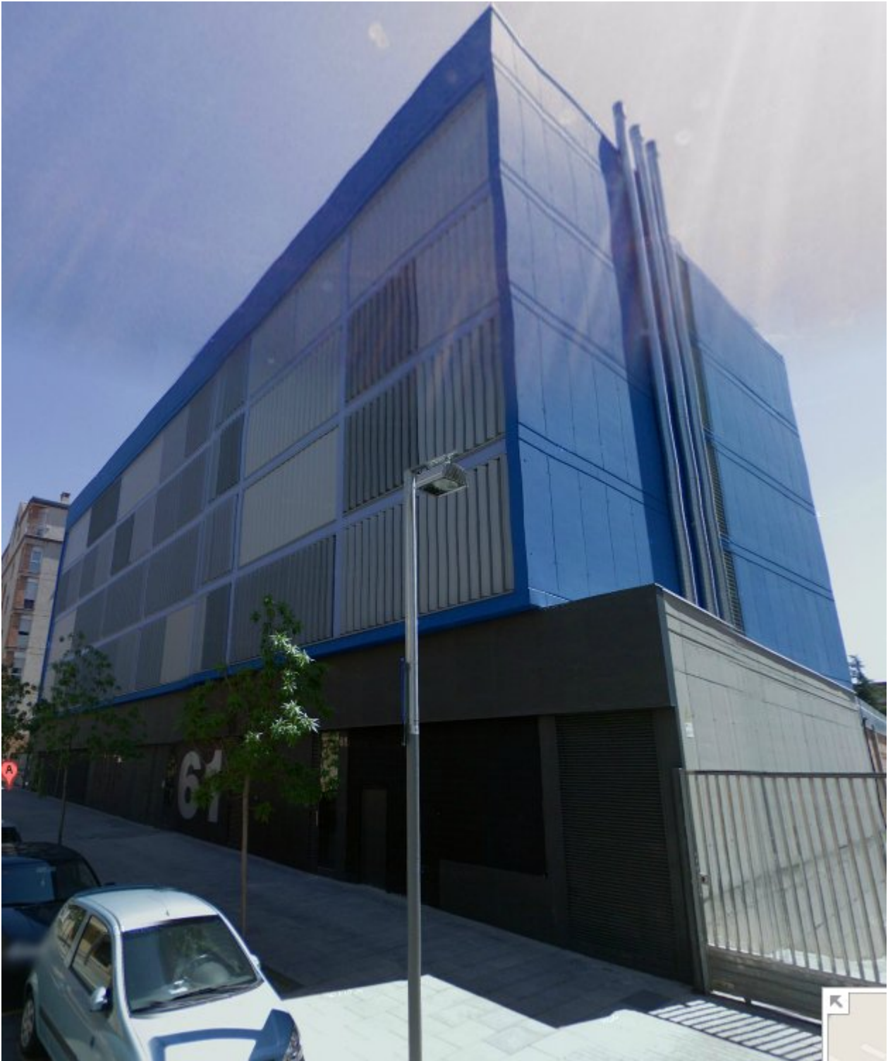
edificio de regesa en c/la selva 57-61 donde se encontró la nota en el popular distrito barcelones de Nou Barris
